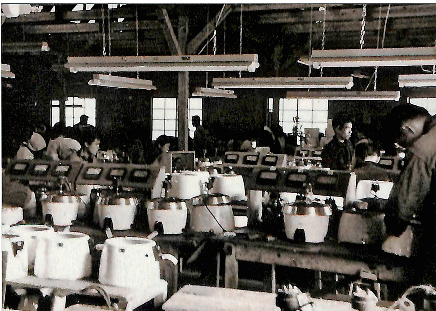
図24 光伸社工場に導入されたベルト コンベアー
